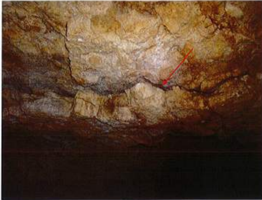
Illustration 5 : écaille partiellement désolidarisée, au toit de la cavité du site 2.
