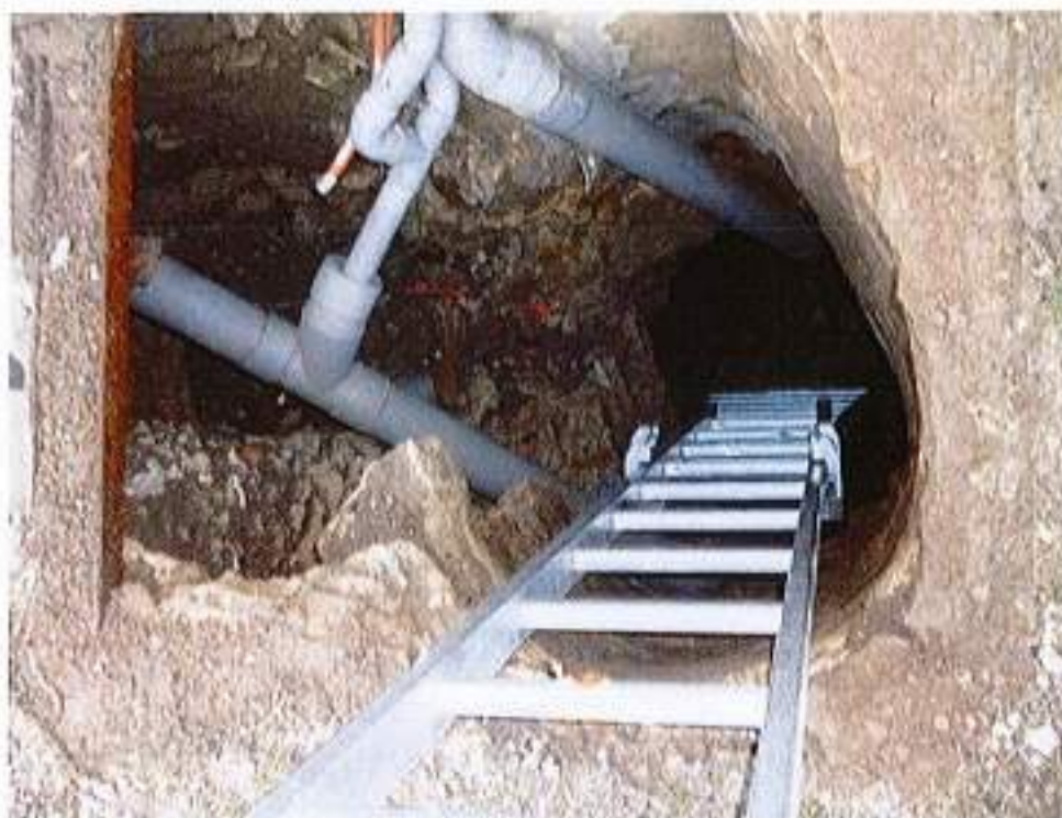
Illustration 4 : Puits d'accès à la cavité du site 2
