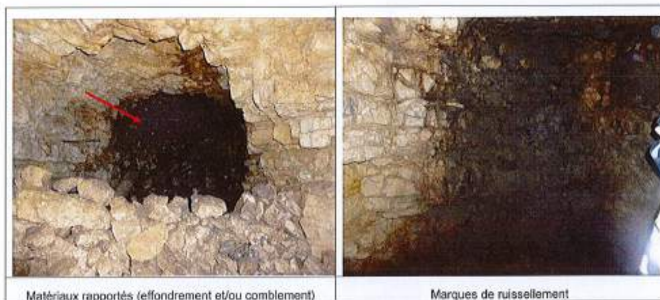
Illustration 7 : Vues de zones de la cavité à l'opposé du puits d'accès
