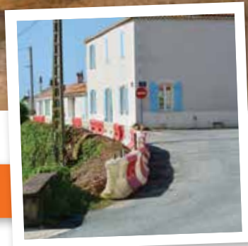
Page 10 : Travaux de voirie
